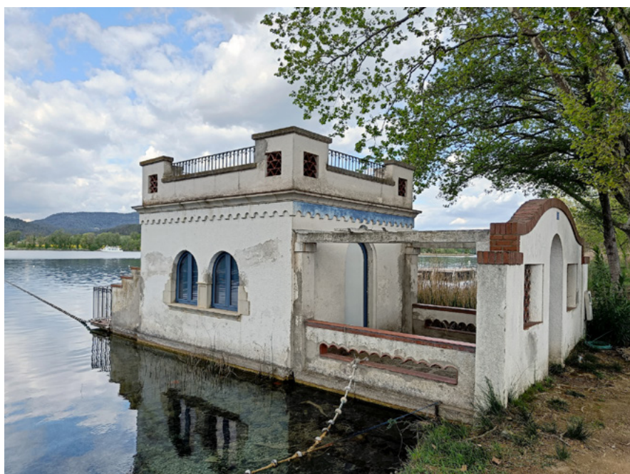
Estat de la pesquera abans de la reforma - Foto CNB
