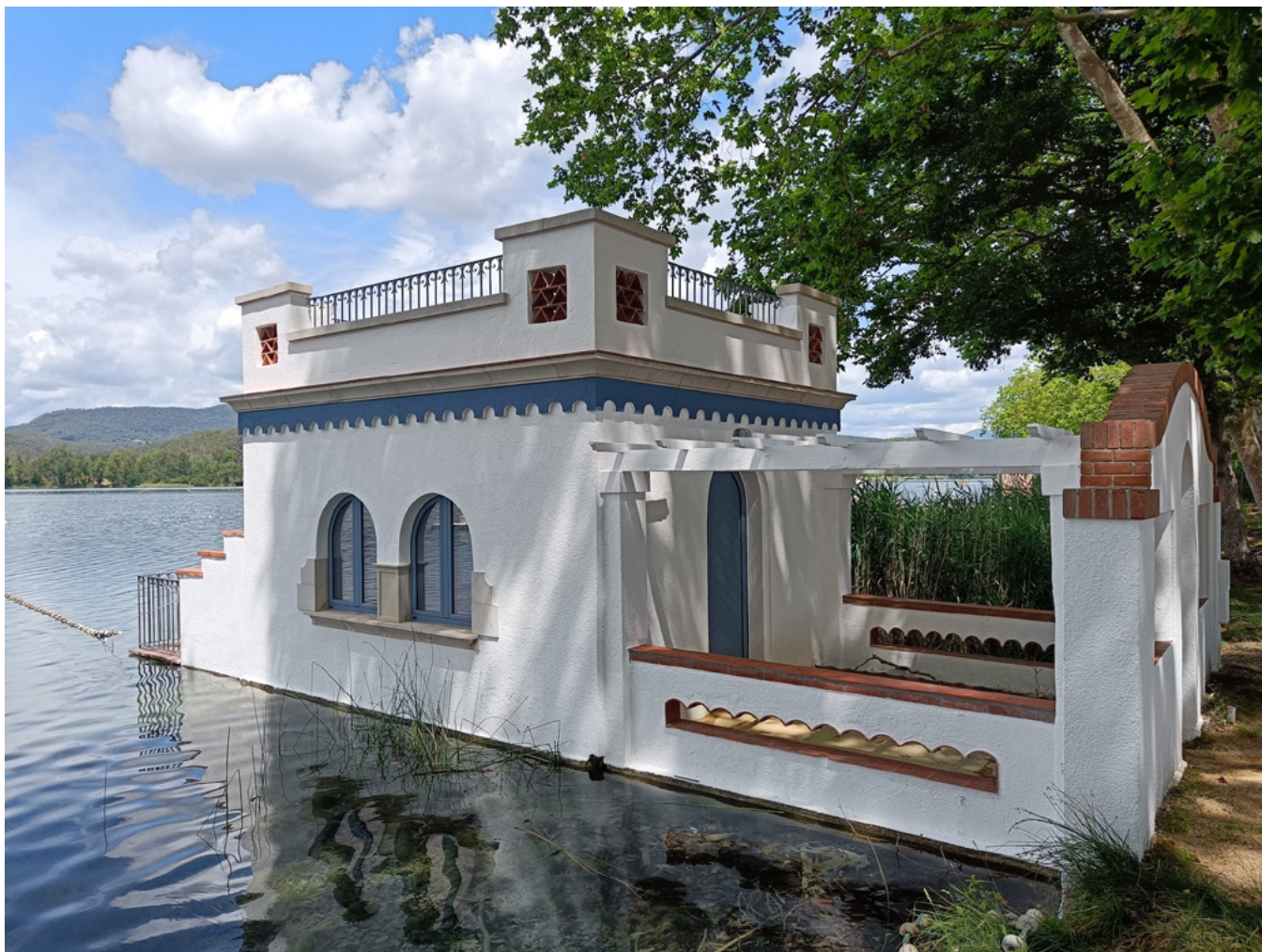
Imatge de la pesquera un cop finalitzades les obres · Foto: CNB
